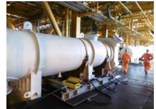
Nouvelles glacières flottant le long du corridor d'accès central.
